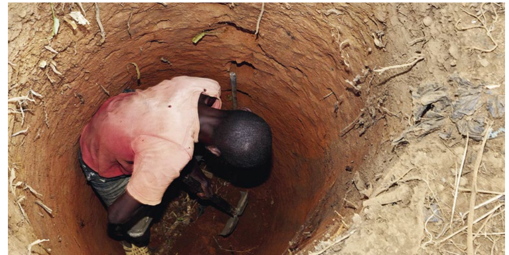
Ein Dorfbewohner gräbt ein Loch für eine Latrine.
