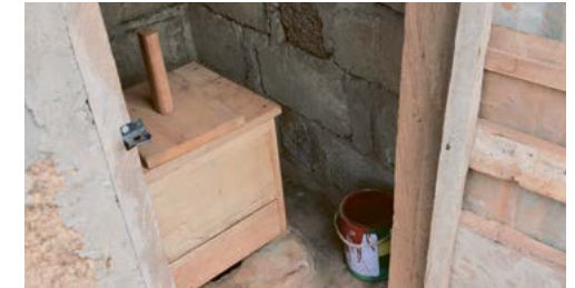
1 von nur 4 Latrinen in Akyem Mampong
