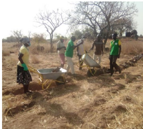
Bau eines Schutzwalls (verhindert Erosion)
